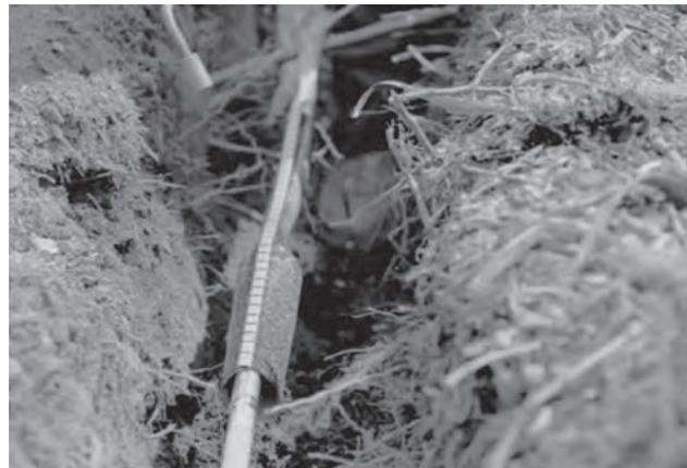
CFSMスリーブをケーブルの損傷部分に巻き付け、標準のトーチで収縮させるだけです。
