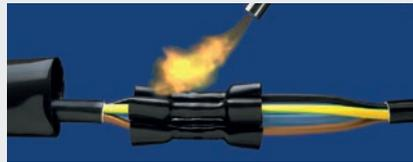
Die mit Heißschmelzkleber beschichteten Innenmuffen werden über die Verbinder geschoben und aufgeschumpft. Dabei schmilzt der Kleber und gewährleistet eine zuverlässige Abdichtung gegen das Eindringen von Wasser.
