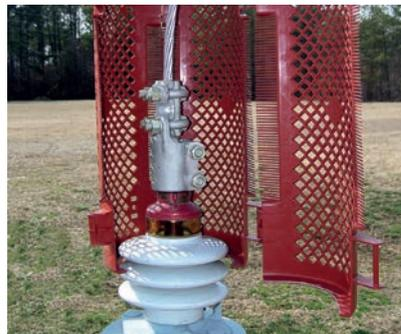
BCAC-IC mit geöffnetem Käfig (Gehäuse) während der Montage
