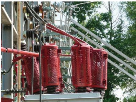
BCAC-IC mit geschlossenem Käfig (Gehäuse)
