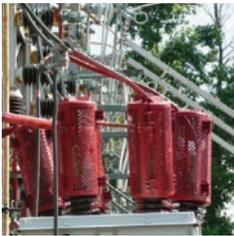
Stützisolatoren für Sammelschienen werden mit BCIC Kunststoffgehäusen abgedeckt. Den Verschluss und die Isolierung der Seiten übernehmen dabei Schrumpfschläuche. Damit werden Isolationswerte erreicht, die Kurzschlüsse und Erdschlüsse durch sich nähernde Kleintiere weitgehend ausschließen
