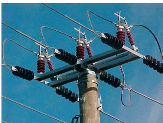
Leitungsstützisolator in Verbundbauweise
