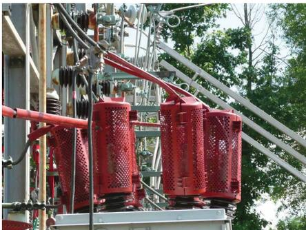
BCAC-IC mit geschlossenem Käfig (Gehäuse)
