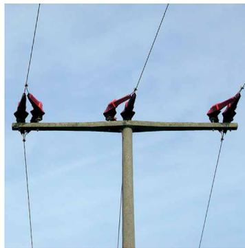
2 Hauben in paralleler Anordnung bei „doppelter Sicherheit“
