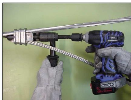
**Paso 5A)** Coloque el socket apropiado para la aplicación (nº19 - mm) en la herramienta eléctrica y la acople al tornillo actuador.
