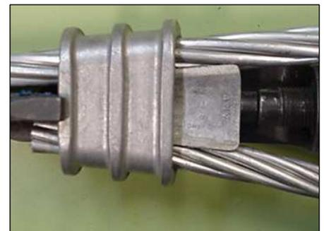
**Paso 3)** Posicione el conector de forma que el tornillo actuador esté centralizado y perpendicular al componente Cuña.
