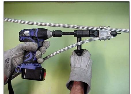
**Paso 2)** Después de posicionar el extractor en la cabeza de retención, insiera ese último en el conector, de manera que la Cuña fique volteada para el operador.
