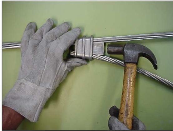
Finalice la fijación del conjunto ("C" + Cuña + Cables) utilizándose de un martillo, para fijar la Cuña, con algunos leves golpes.
