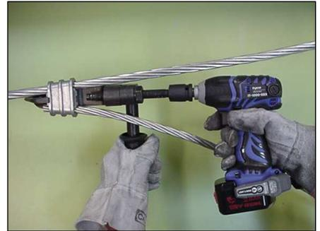
**Paso 9)** Invierta el sentido de rotación de la herramienta eléctrica, para retroceder el tornillo actuador y soltar el conector de la cabeza de retención.
