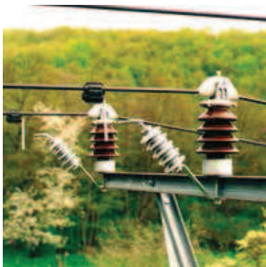
Typiskt montage för 12 kV systemspänning
